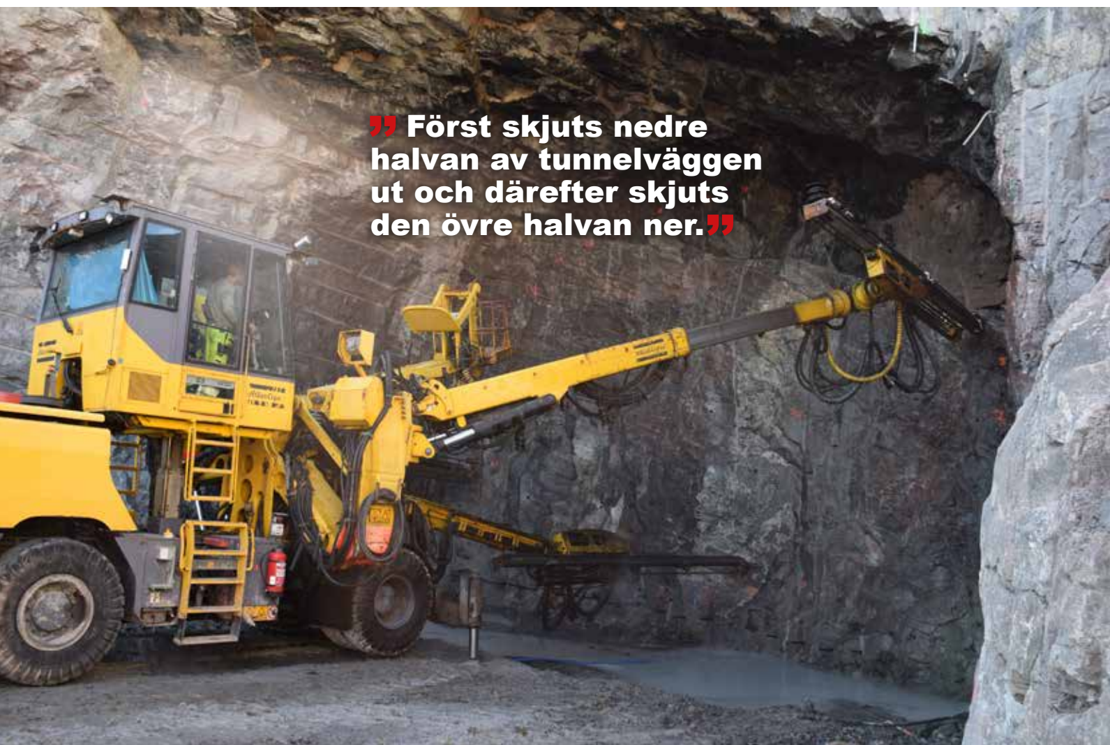
De tre bommarna ger maskinen en täckarea på 198 m 2 . Dessutom finns en personkorgslyft för servicearbeten.
