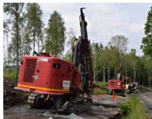
Pontus Lorentsson kör en Stonepower Scorpion borrsvagn för Svevia. Berget måste bort för att ge plats för vattenrören från högvattenreservoaren.
