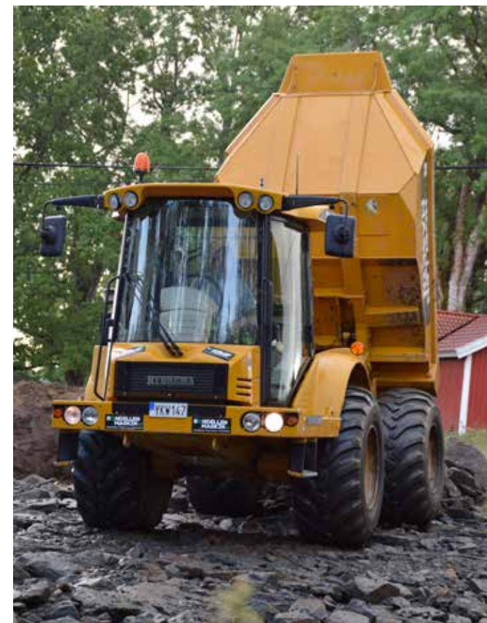
En inhyrd Hydrema 912FS från 2018 är perfekt lämpad för bergkörningen vid högvattenreservoren. Peter Johansson från Svevia ser till att den har förare.
