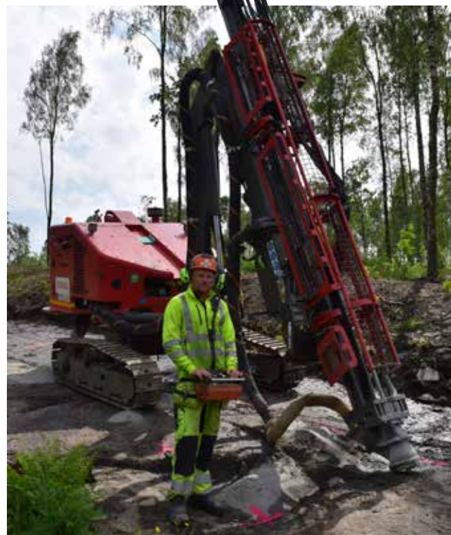
Pontus Lorentsson kör en Stonepower Scorpion borrsvagn för Svevia. Berget måste bort för att ge plats för vattenrören från högvattenreservoaren.
