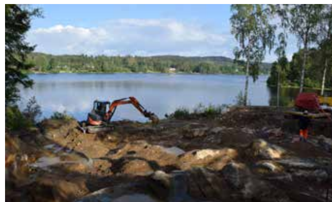
Stenkullen Entreprenad har en minigrävare på plats på Bocköhalvön. Deras Hitachi 52U är inlånad och Ola Rosenkvist på Svevia Bergtäckning täcker av i samband med borrhningarna.
