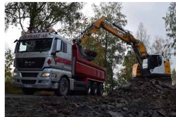
Sprängstenen i rörgraven ska bort. Mårten Strömgren lastar ett lass på Tommy Johanssons MAN 35.480 som han kör till Bugärdekrossen.
