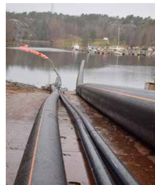
Vid Hålkedalsbron svetsas alla rör för projektet. Det är Väst kustens Plastsvets & Entreprenad i Uddevalla som ser till att PE-rören stumsvetsas en efter en, för att sedan dras ut i vattnet.
