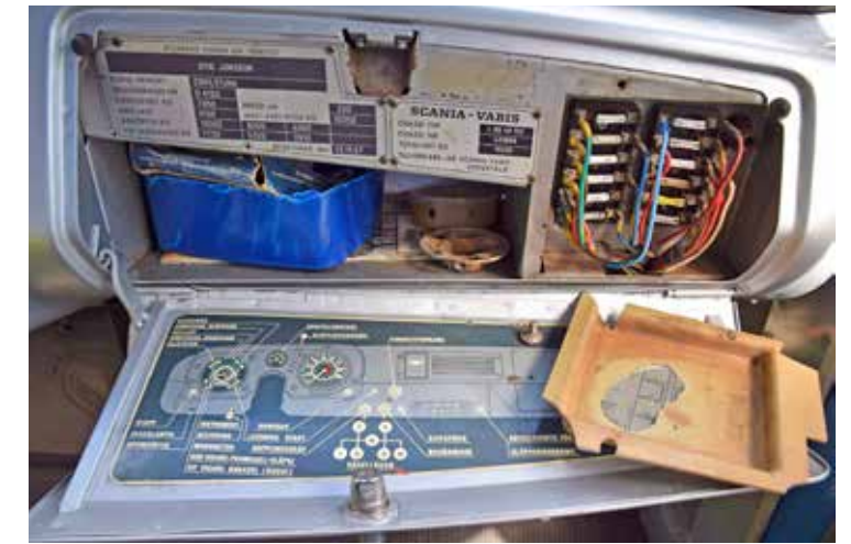
Ett överkomligt antal säkringar döljer sig bakom plastkåpan innanför handskfacksluckan. Fullt tillräckligt på den tiden.
