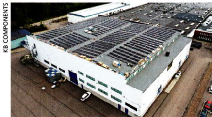
KB Components anläggning i Örkelljunga i norra Skåne.
