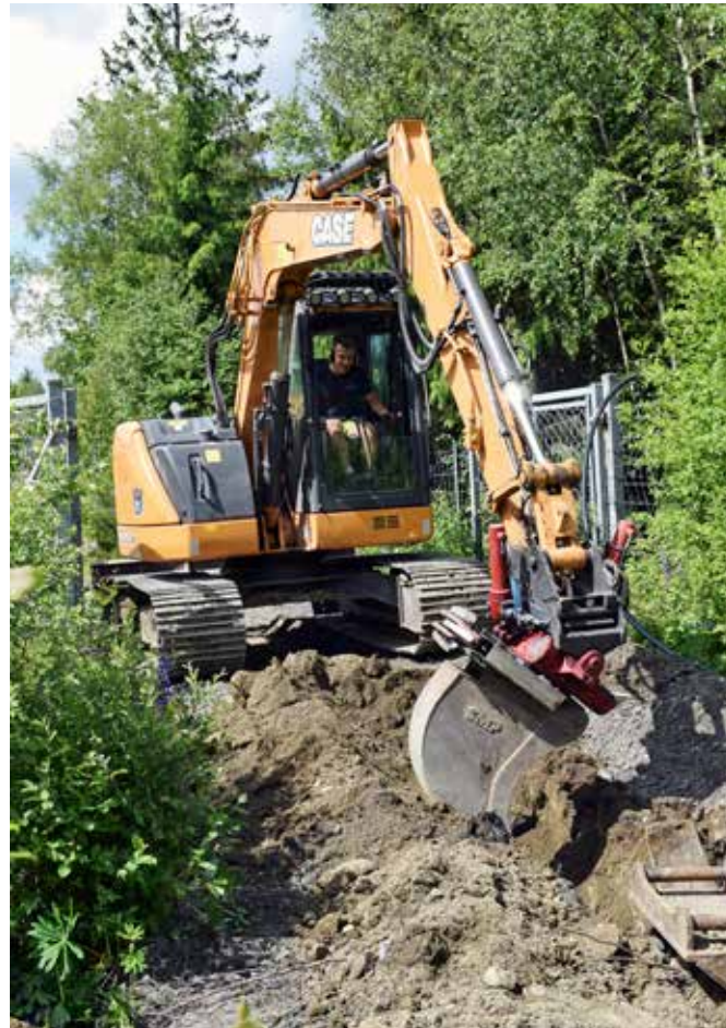
Albin Olofsson är i Stora Bugärde och gräver ner fiberslang med en Case CX75C SR. Maskinen går utmed telemasterna mellan Mölnlycke och Hindås.
