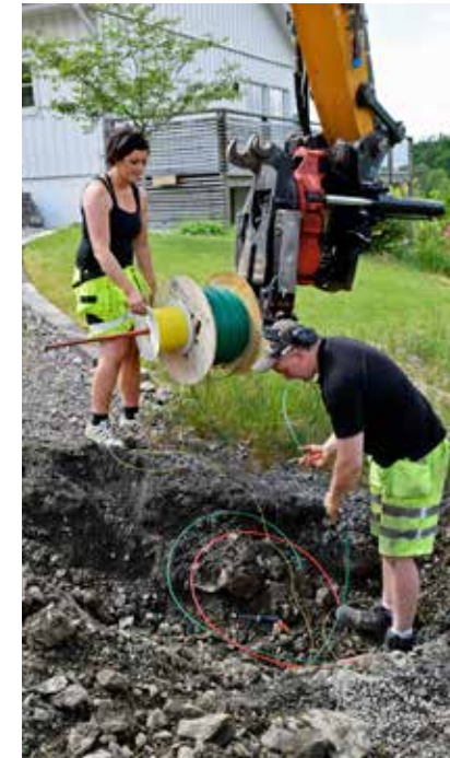
Vid fiberarbetena är allt långt ifrån maskinkörning. Jonas får skarva fiberslang också och får värdefull hjälp av Isabelle.
