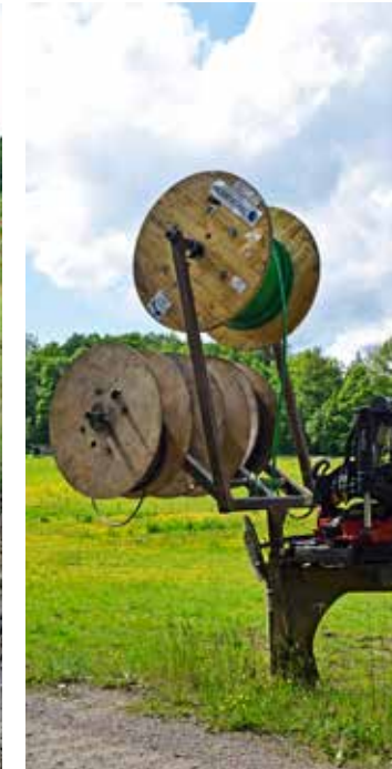
Kabelplojen kan bära fem rullar på stativet. Helst plöjs kabelslangen ner men är det för trångt eller för mycket sten får man gräva.
