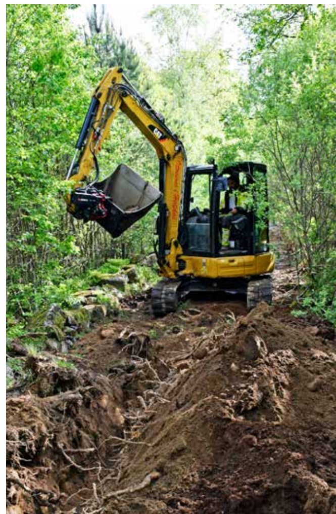
Peter Johansson återställer marken efter att kabelrören lagts ner. En 5-tonns CAT 305E är alldeles lagom i den täta snårskogen.
