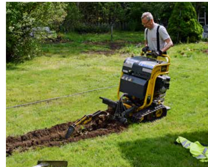
Leif Sörensen har jobbat för Ottossons i fyra år och gräver oftast för kabel med kedjegrävaren, en AF Traction med 60-svärd och Hondamotor.
