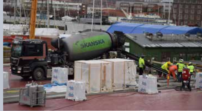
Jonny Rodhén på PA:s Maskintjänst AB, Varekil bistår med betong med en MAN TGS 35.480 betongroterare.
