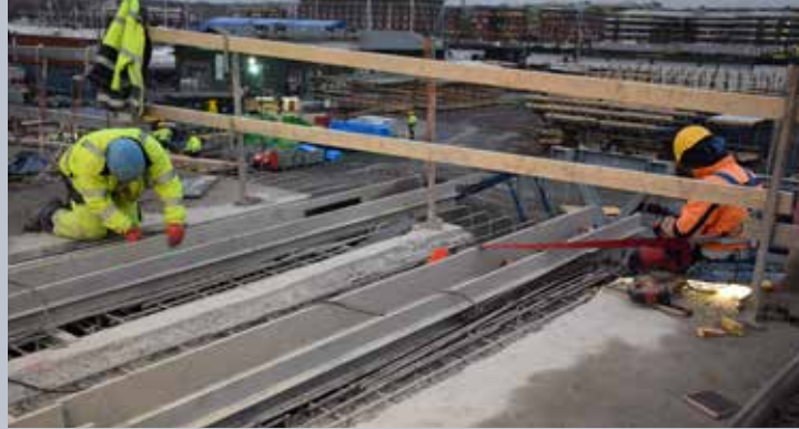
Där spårvagnsspåren ska ligga behöver justeras några centimeter. Marginalerna är ytterst små så betongen får bilas bort och justering görs till exakt mått.
