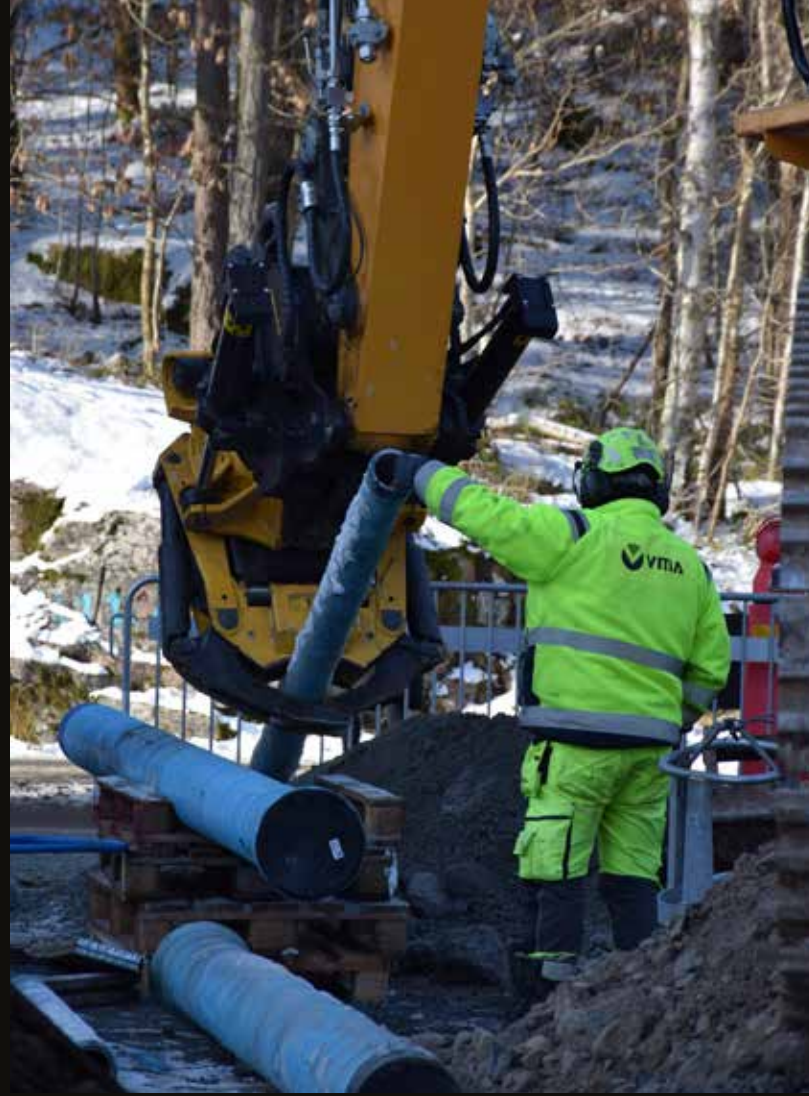
Gripen på tiltrotatorn är en ovärderlig hjälp. Jimmy håller ett stadigt grepp i röret när Jerry säger det i rätt längd.
