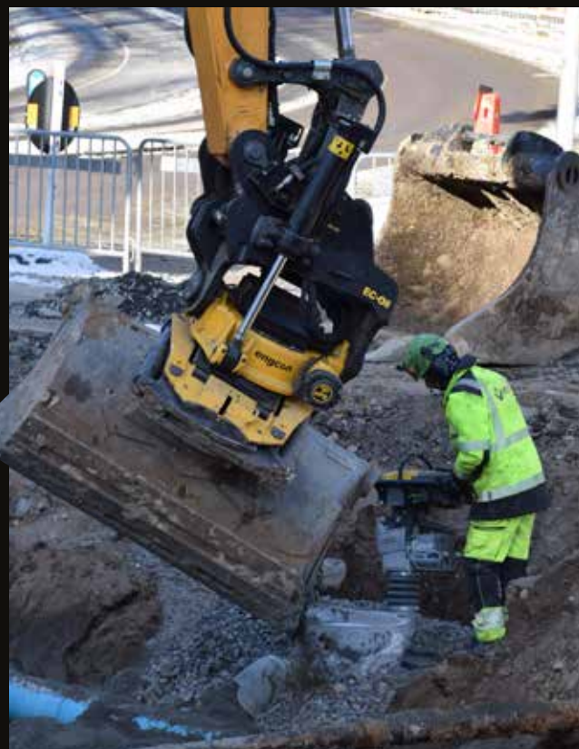
Finlir är inga större bekymmer bara man har känsla för det och att det är en bra tiltrotator. Den är en Engcon EC233 med grip och EC-oil-fäste.
