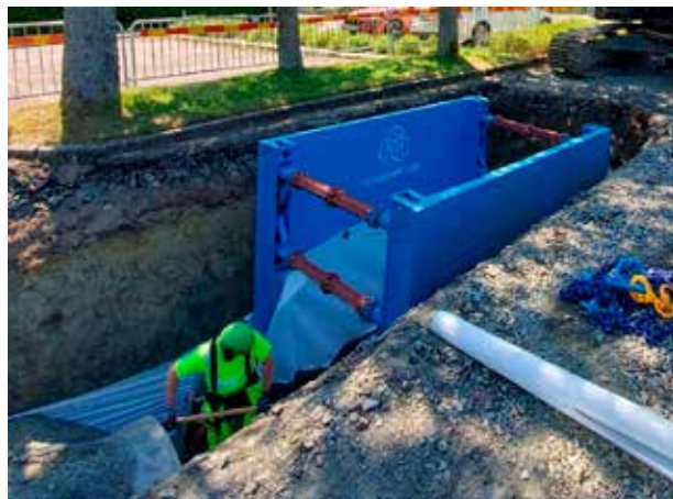
Med schaktkassetten från Kojapo kan de arbeta säkert utan risk att skadas vid ras. Speciellt viktigt där schaktbredden begränsas.
