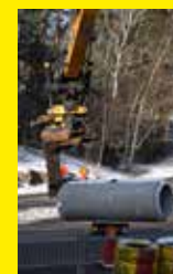
Lerbergs_010: Ett av tillbehören är rörläggaren eller rörliften. Den är nödvändig för de kraftigare rören där gripen inte räcker runt.
