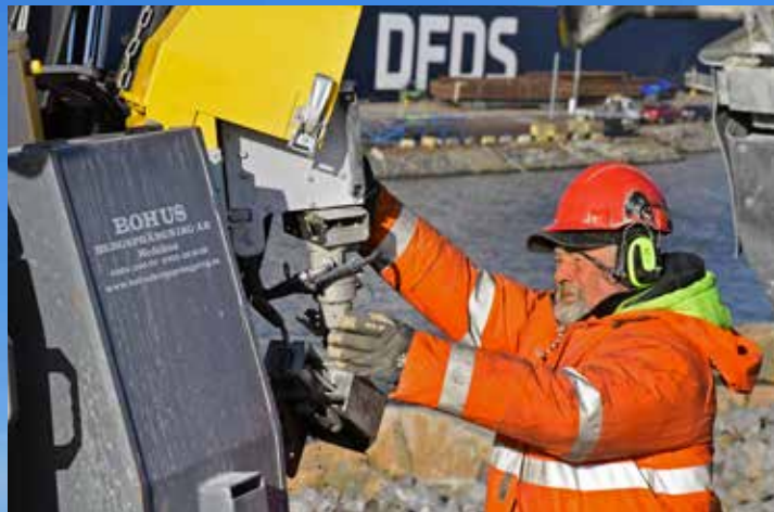
Christer Jönsson måste emellanåt slipa borrkronan för att den lätt ska äta sig ner i det hårda berget.
