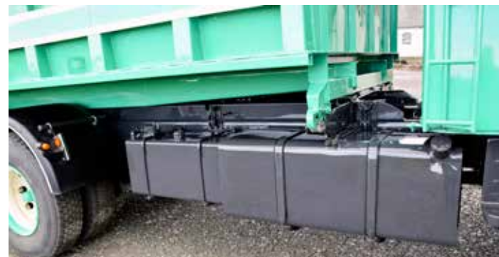
Bränsletanken var i sämre skick. Den fick svetsas upp då den var rostig och läckte diesel.
