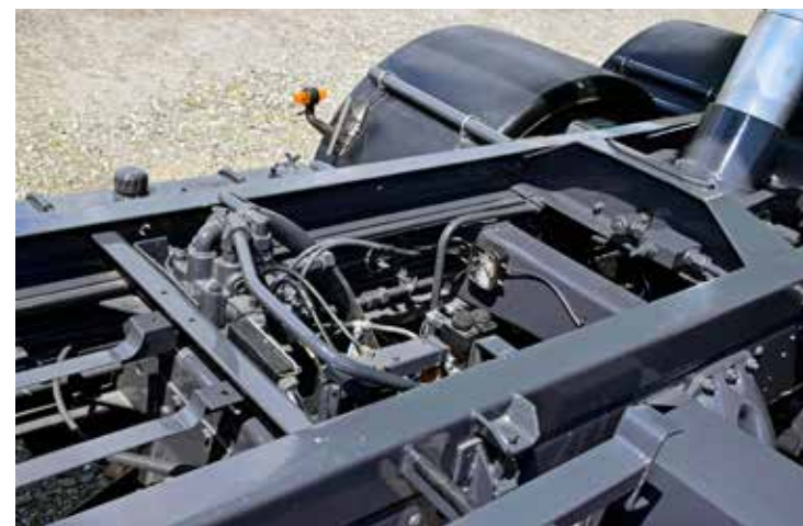
Ramen innebar en hel del jobb. Den som så många andra led av dubbelramarnas obligatoriska sjukdom rostsprängning.
