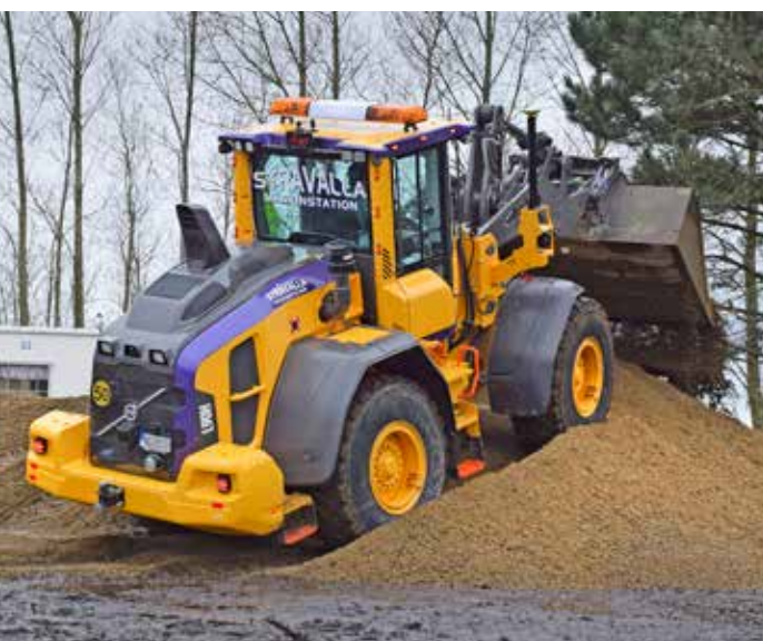
På Jonabs arbetsområde där ett industrispår ska anläggas får Christoffer Svensson stacka bärlager med sin Volvo L90H från 2020.
