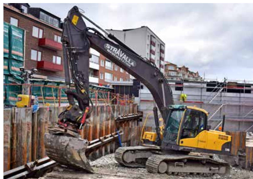
Där hjulgrävaren inte med säkerhet skulle klara uppdragen ställdes i stället firmans Volvo EC240EL från 2011 på plats. Här ska betongtunneln övergå till bergtunnel.
