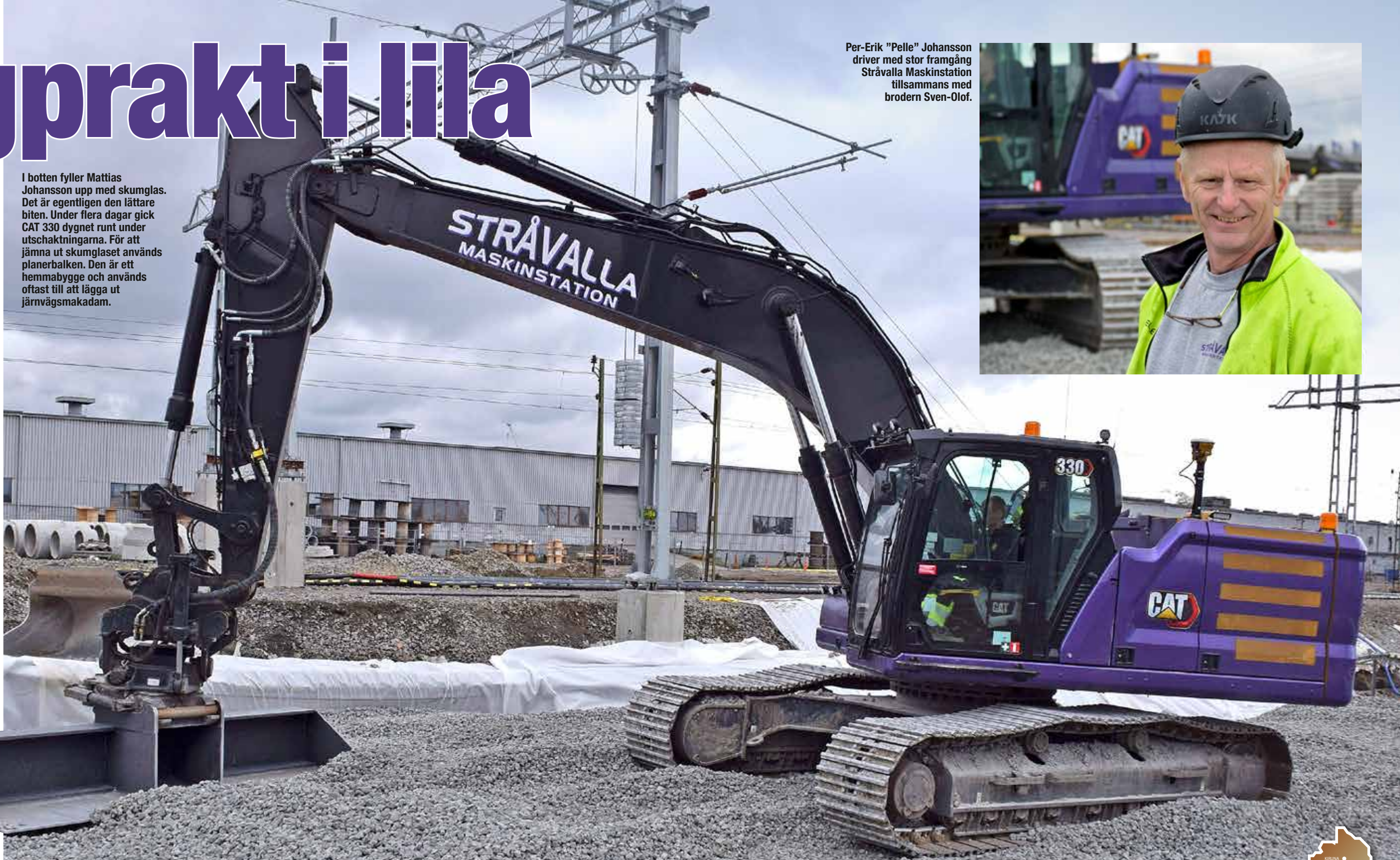
Med firmans näst senaste maskin, en CAT 330 lägger Mattias Johansson tvärkanalisation med QA4-kanal för elkablar. Det ska mätas noggrant så det kommer på rätt nivå.
