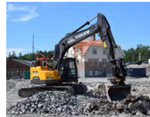
Dalbo Schakt_002: Firmans Volvo ECR235EL är kompakt med sin korta motvikt. Det är förvisso gott om svängrum på bygget, men nästa gång kan smidigheten komma bättre till pass.
