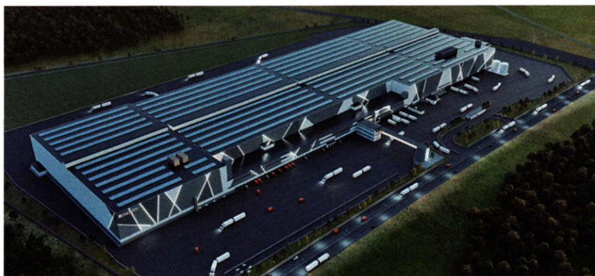
Dagabs nya anläggning som byggs i Bålsta nordväst om Stockholm.
