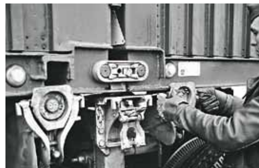
Här fästs hjulsatsen under två sammankopplade containerenheter. Slutligen drogs elkablar och luftslangar under containern och kopplades i hjulsatserna.
