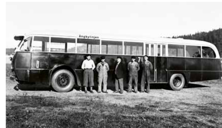
Stockholms Spårvägars bulldoggbuss typ 8601, tillverkad från 1936 till 1938 med framflyttad förarplats, och där motorn satt helt framför framaxeln.
